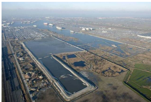
Baggerwerken Toyotakaai (foto's MBZ)
